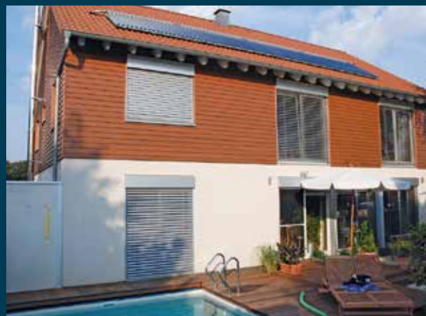
Einfamilienhaus mit BIOCAT KS 3000 Kalkschutzgerät
